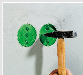
Åbn betondåserne for montage.
