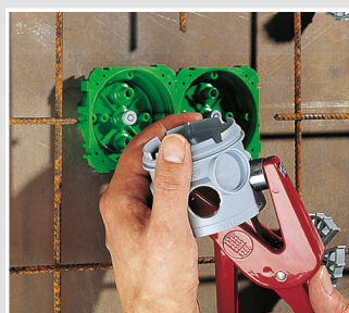
Lav en lednings- eller kabelindføring (hultang eller hulskærer).
